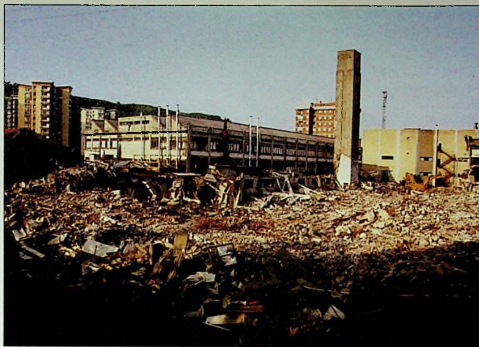
DERRIBO. El derribo de "Contadores" no tiene la necesaria aprobación del plan especial.
