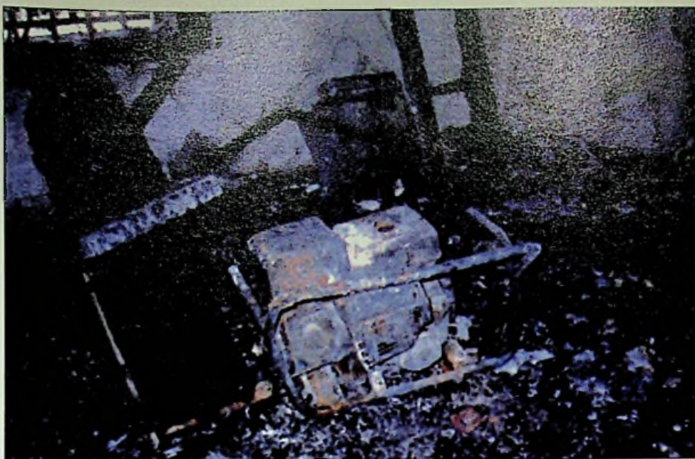
GENERADOR CALCINADO. Es lo único que ha quedado del gaztetxe incendiado.
