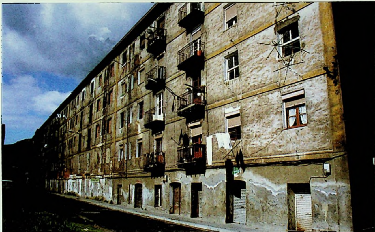
CASA LARGA DE ELORRIETA. El derribo comenzará en junio.
